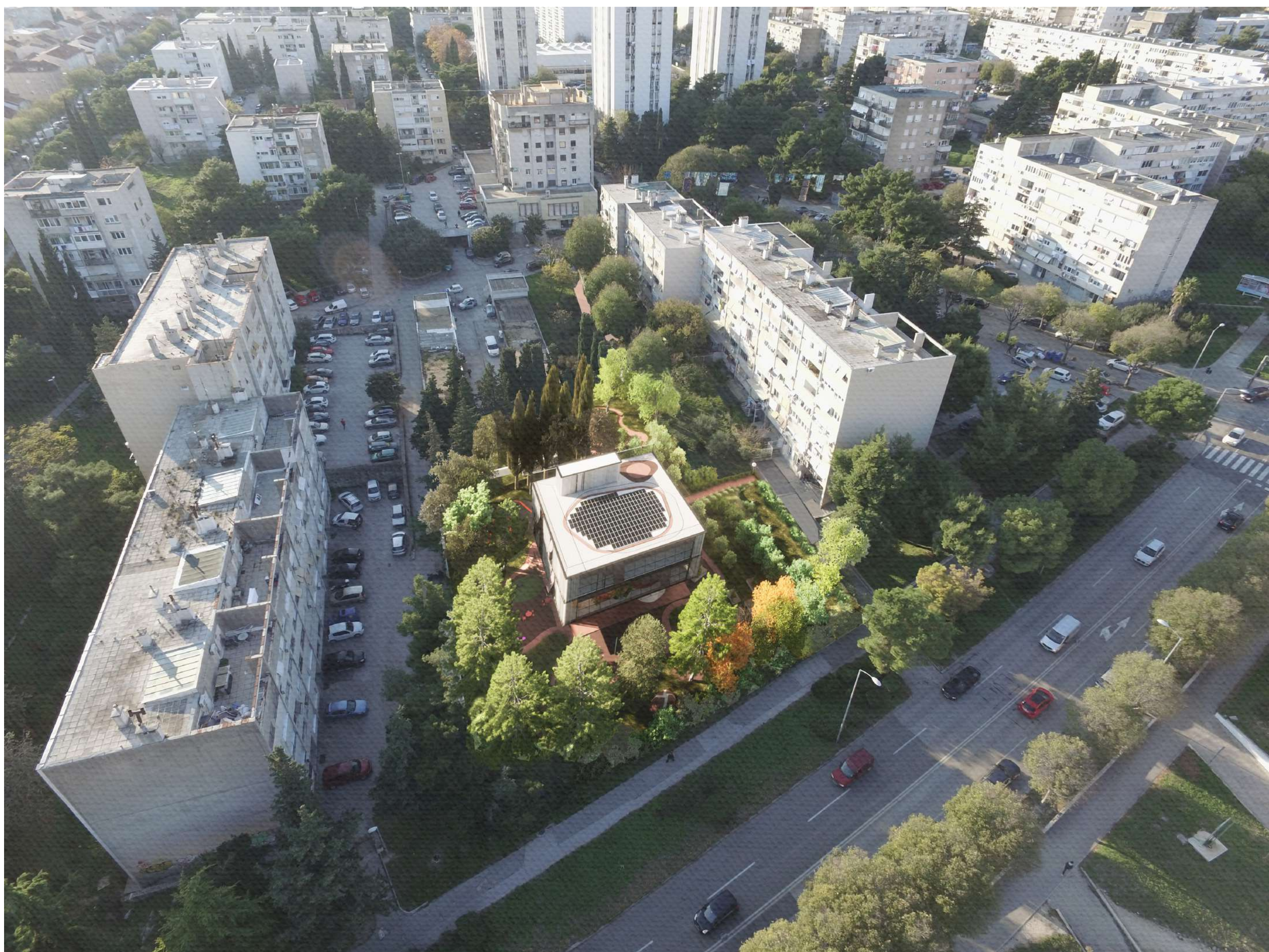
pogled na lokaciju
