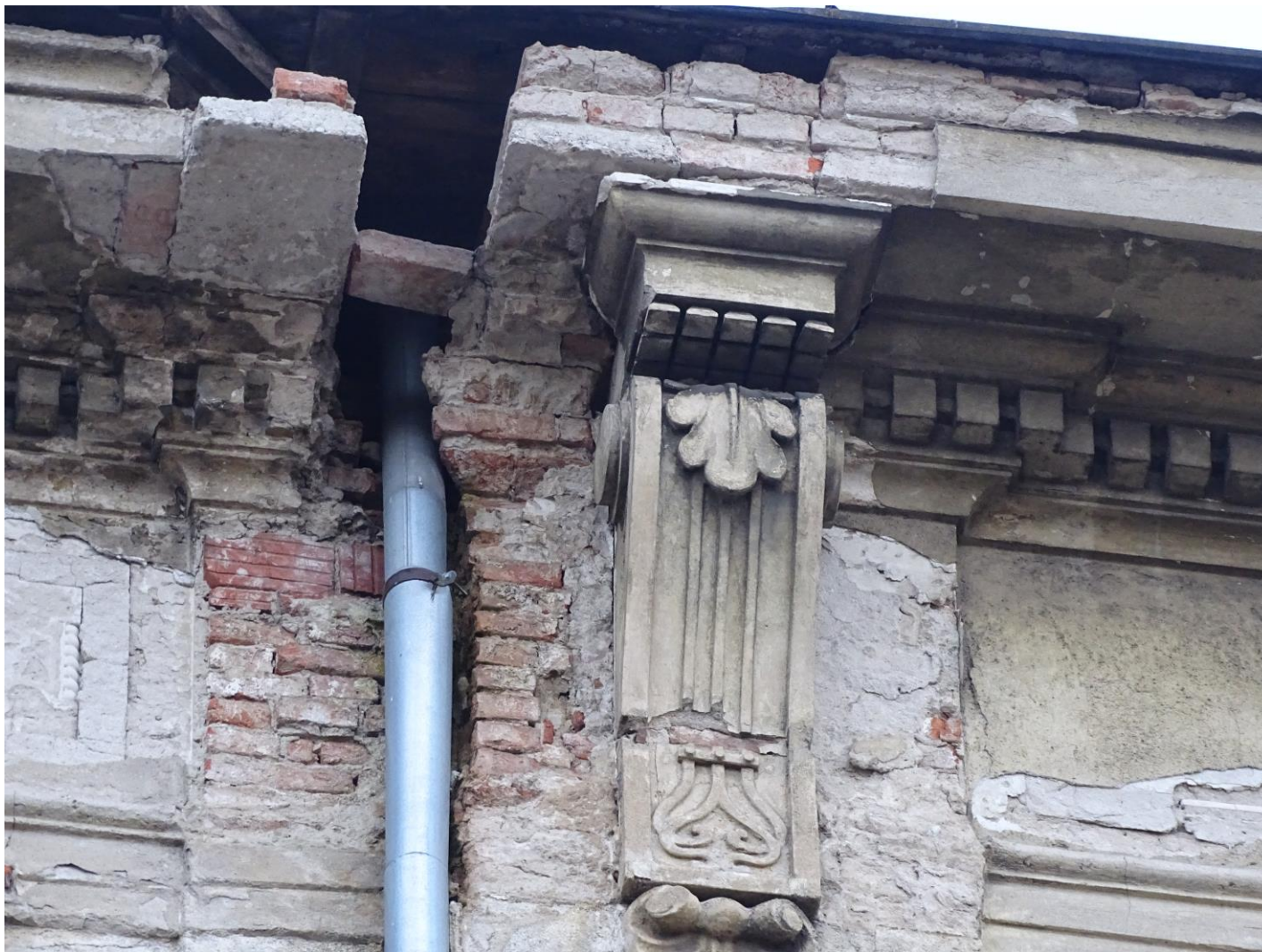
. Oštećenje vijenca
