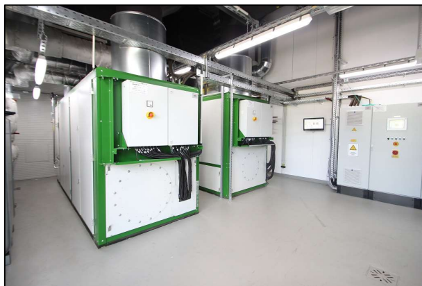
1x avus 500plus i 1x agenitor 408 u zvučno izoliranoj kapsuli (70dB(A) na 1m)
